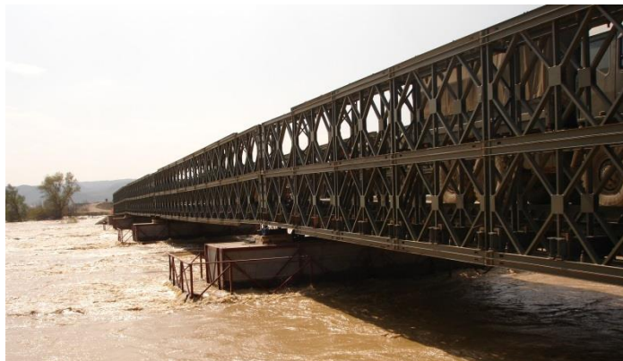
Figura n.º 10: Puente Bailey tendido sobre el río Ebro (Fuente: RPEI-12).
