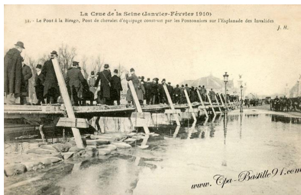
Figura n.o 2: Puente Birago utilizado durante las inundaciones parisinas de 1910 (Fuente: Cartes Postales Anciennes).
