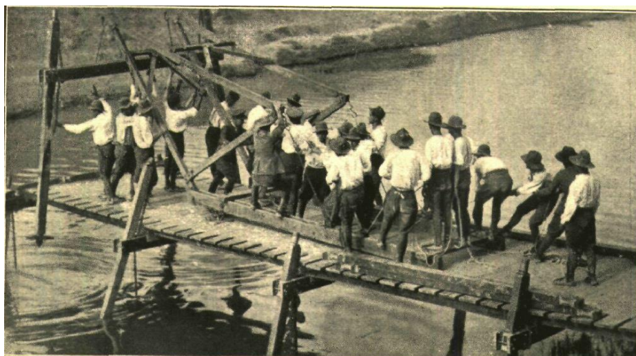
Figura n.º 9: Lanzamiento de un puente de vanguardia Marvá en el río Guadaira (1934) (Fuente: Carcaño, 1934: 8).
