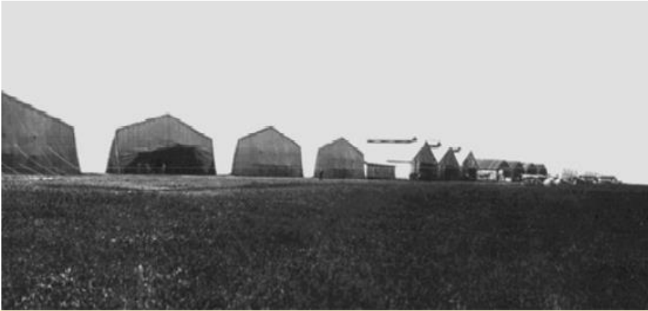
Panorama que presentaba la E.A.M. "El Palomar" con la llegada de la misión aérea italiana. En primer plano los cobertizos desmontables tipo "Varesse".
