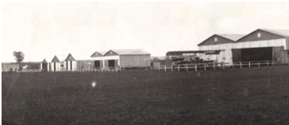
A medida que el presupuesto lo permitía, la E.A.M. se ampliaba con nuevas y necesarias instalaciones. Año 1916.
