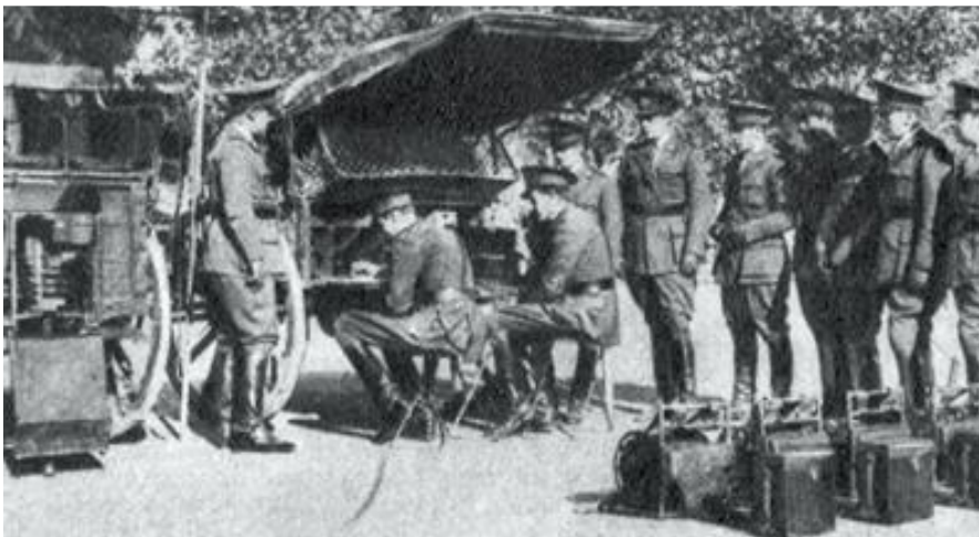
Las comunicaciones también progresaban. Unidad móvil para instalaciones telefónicas.
